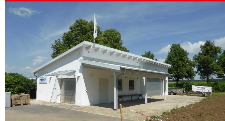
Das erweiterte DLRG-Gebäude im Freibad Kösing
